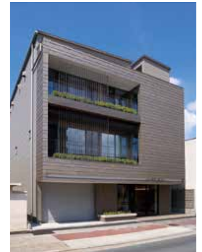
都島大東町オフィス外観
